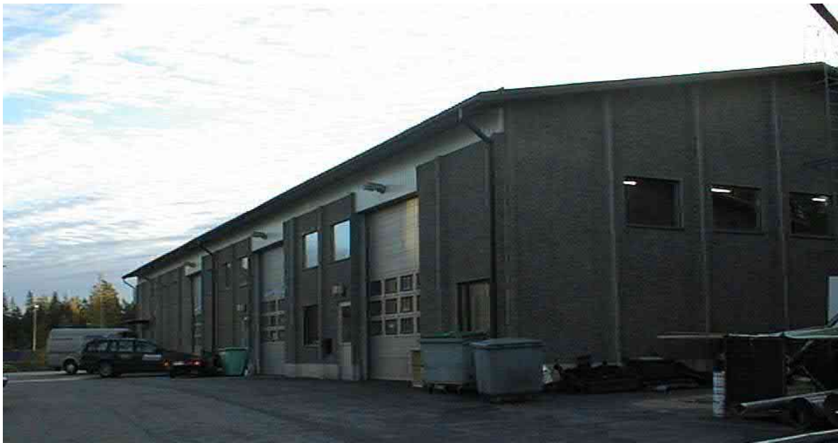
Hallitilat B1 ja B2 (julkisivu pihalta)
